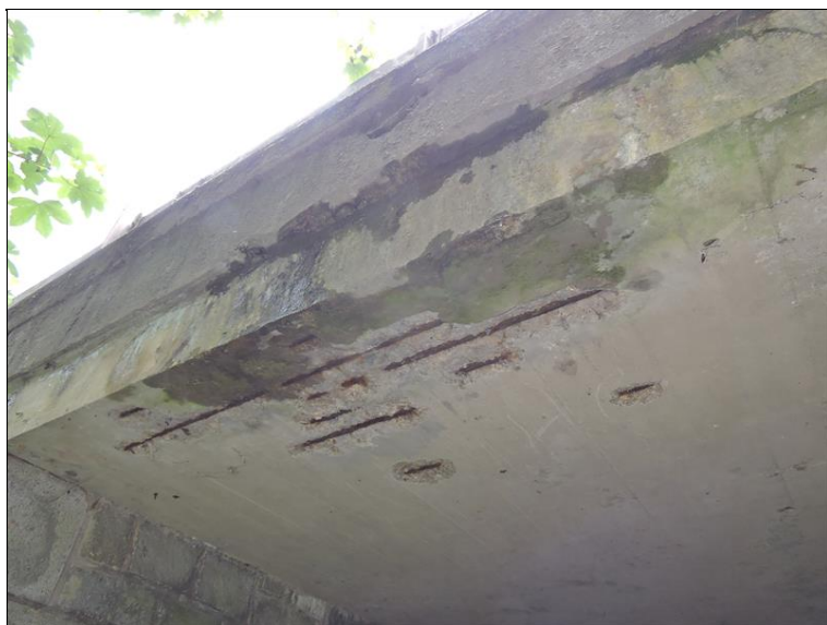
Opadané krycí vrstvy, zkorodovaná výztuž, zatékání pod římsou, mechy - římsa na levé straně
